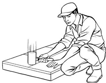
**F** Bater com um maço de borracha na tijoleira de forma que fique totalmente aderida 100% à argamassa.
